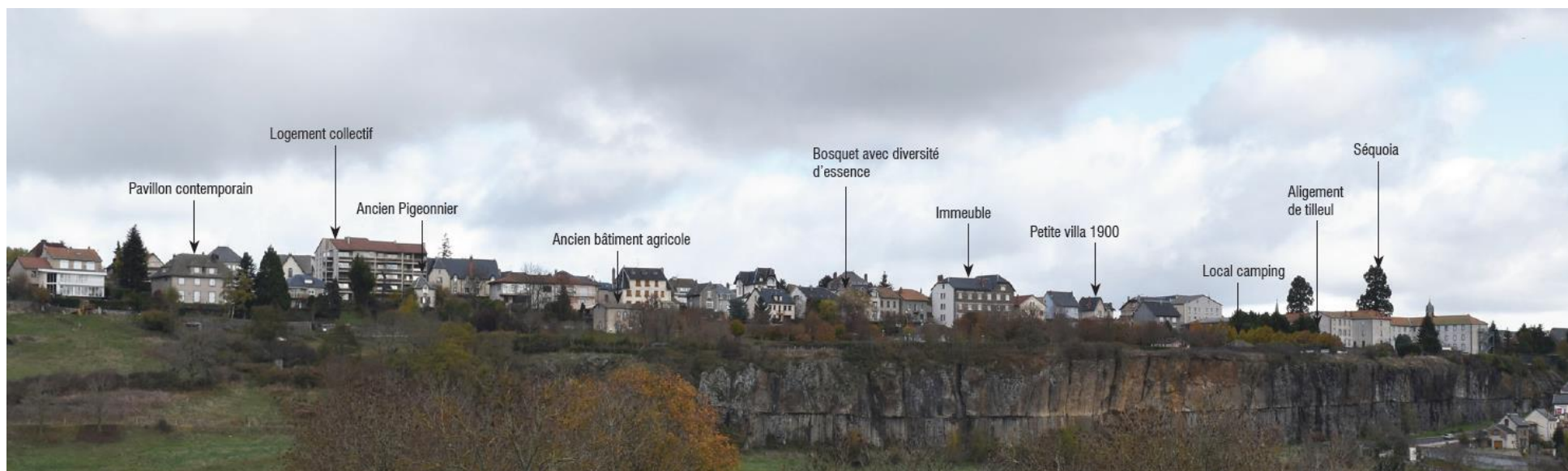
Figure 2 - vue des Orgues : camping en promontoire et front bâti
