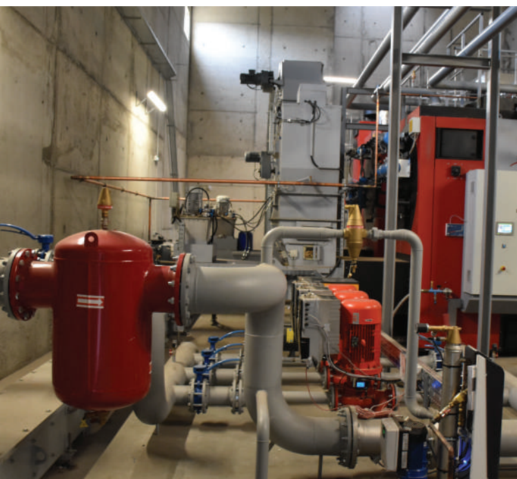
RÉSEAU DE CHALEUR DE BESSERETTE
