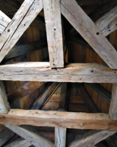
La charpente de la tour
