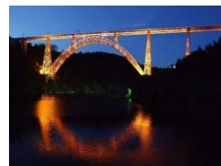
Viaduc de Garabit
