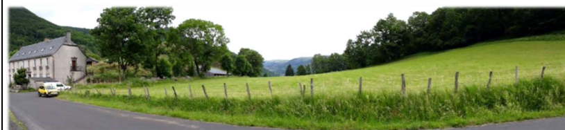
Vue sur le site dans le prolongement de la mairie, depuis la RD57 - © Campus Développement
