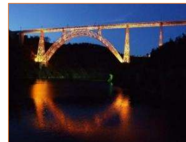
Viaduc de Garabit
