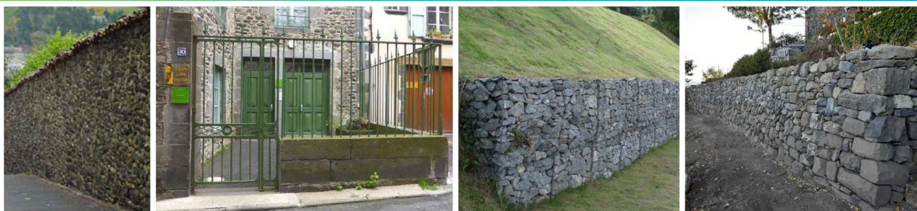
Exemples de murs en en pierres locales couvert en tuile, mur bahut avec grilles ajourées, gabion et pierres sèches
