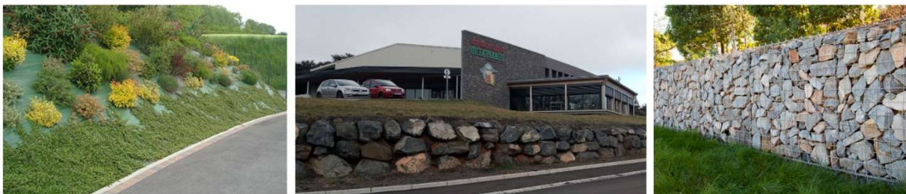
Exemples de talus végétalisé, enrochement de pierre locale et gabion en pierre locale
