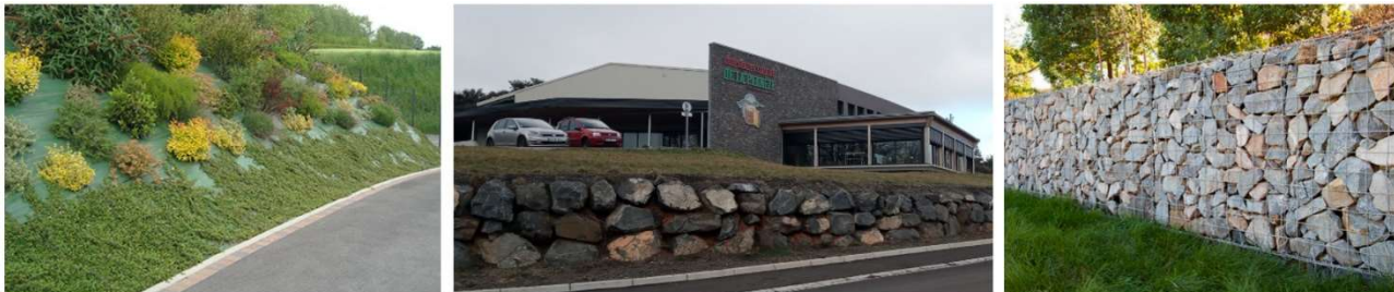
Exemples de talus végétalisé, enrochement de pierre locale et gabion en pierre locale
