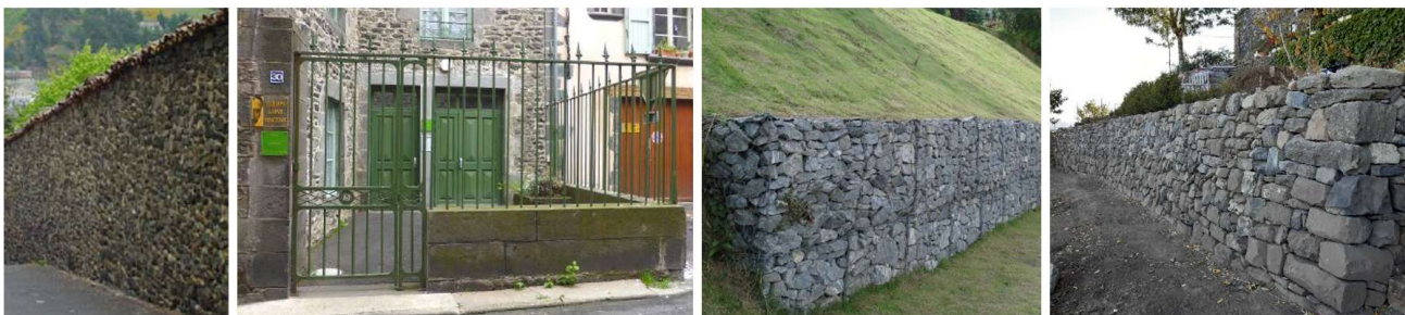
Exemples de murs en pierres locales couvert en tuile, mur bahut avec grilles ajourées, gabion et pierres sèches
