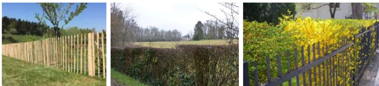
Exemple de clôture en ganivelle, de haie taillée et de grille doublée d'une haie d'essences végétales
