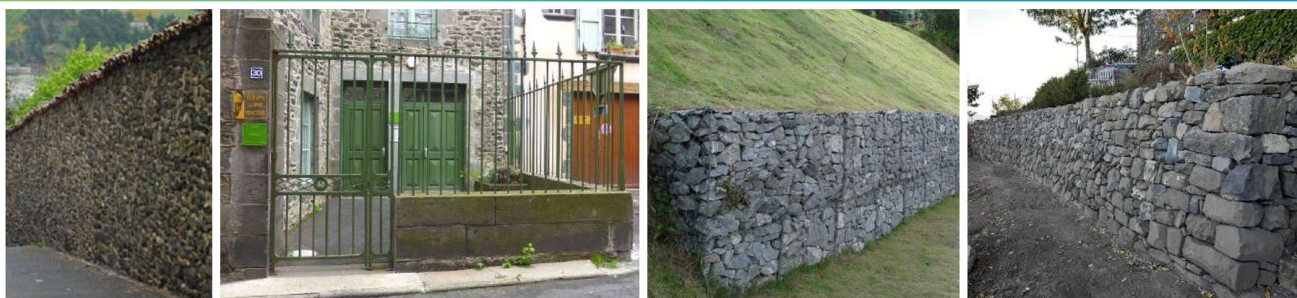
Exemples de murs en pierres locales couvert en tuile, mur bahut avec grilles ajourées, gabion et pierres sèches
