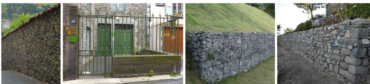
Exemples de murs en pierres locales couvert en tuile, mur bahut avec grilles ajourées, gabion et pierres sèches
