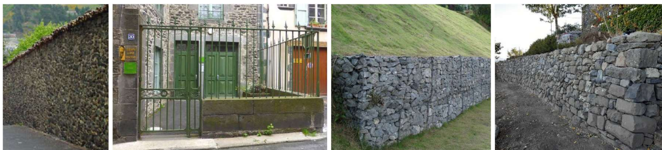
Exemples de murs en pierres locales couvert en tuile, mur bahut avec grilles ajourées, gabion et pierres sèches
