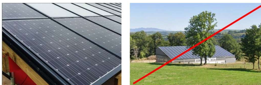
Teinte des panneaux et structures photovoltaïques
