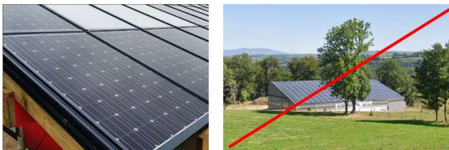
Teinte des panneaux et structures photovoltaïques
