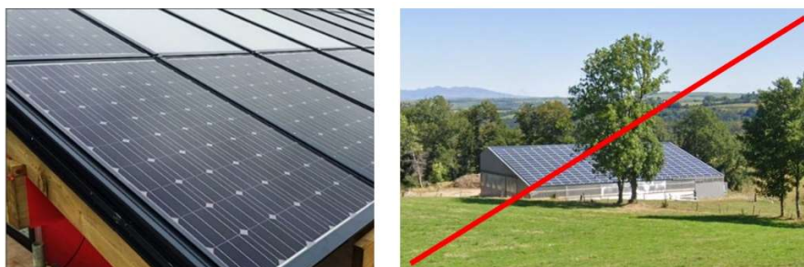
Teinte des panneaux et structures photovoltaïques
