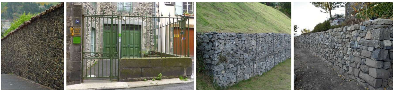
Exemples de murs en en pierres locales couvert en tuile, mur bahut avec grilles ajourées, gabion et pierres sèches
