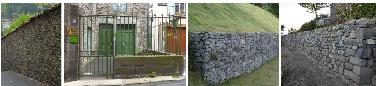
Exemples de murs en pierres locales couvert en tuile, mur bahut avec grilles ajourées, gabion et pierres sèches
