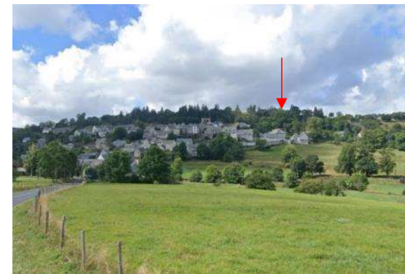
Vue lointaine en direction du site depuis la D813/D112 – Google Maps©
