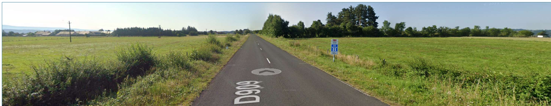
Perspective à l'approche de site du Drop (dans le sens Nord → Sud). Le paysage est ouvert sur les prairies à l'exception du site du Drop encadré par un masque de haies relativement denses - © google maps
