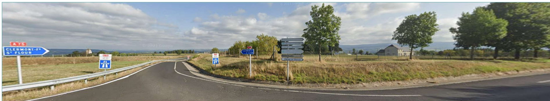
Entrée de l'A75, en situation de déblais - © google maps
