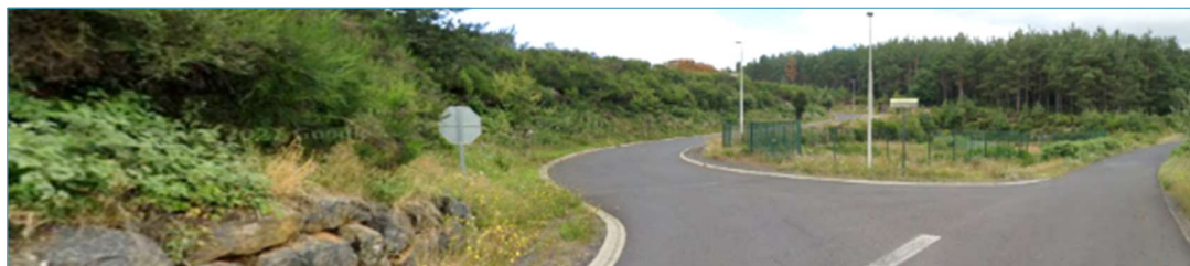
Vue sur la voie d'accès à la zone de la Voreille existante depuis la RD 50 - © Google maps
