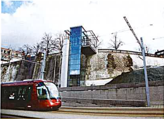
Exemple : ascenseur urbain à Clermont-Ferrand
