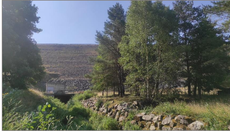
Figure 219 : Barrage de Montézic
