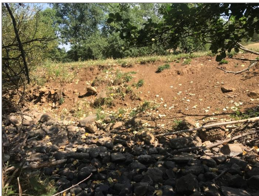
Figure 159 : Zone d'érosion de berges
