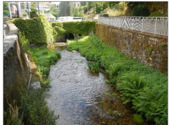
Figure 50 : le Remontalou traversant Chaudes-Aigues
