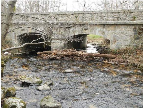
Figure 190 : Pont d'Orlhaguet avant travaux
