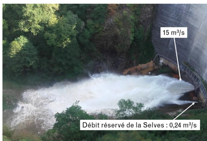
Figure 275 : La Selves sous le barrage de Maury pendant le lâcher de 15 \text{ m}^3/\text{s}
