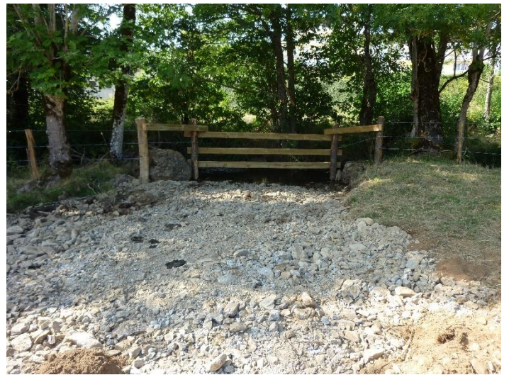
Figure 270 : Abreuvoir direct après travaux
