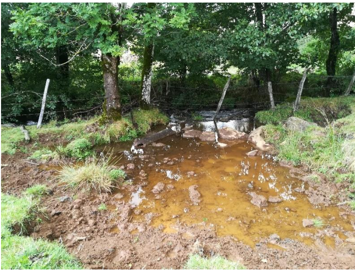
Figure 269 : Abreuvoir direct avant travaux
