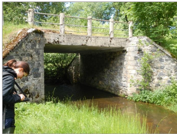
Figure 141 : Seuil au niveau du pont de Lacalm
