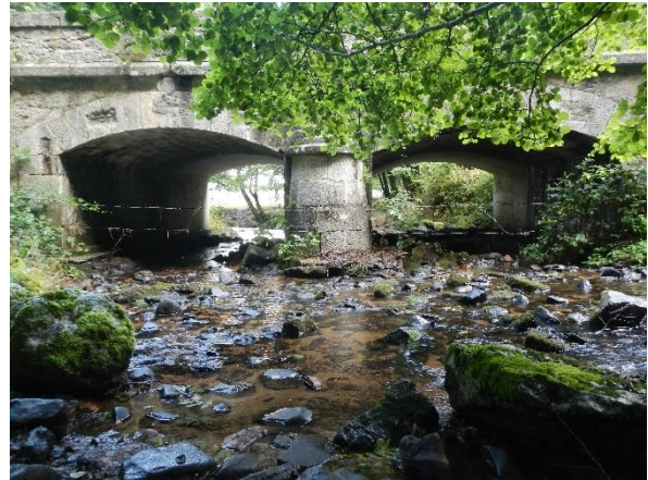
Figure 191 : Pont d'Orlhaguet après travaux
