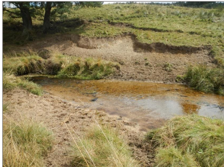
Figure 122 : Passage à gué dégradé
