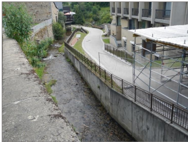
Figure 69 : Cours d'eau rectifié avec berges artificialisées dans Chaudes-Aigues
