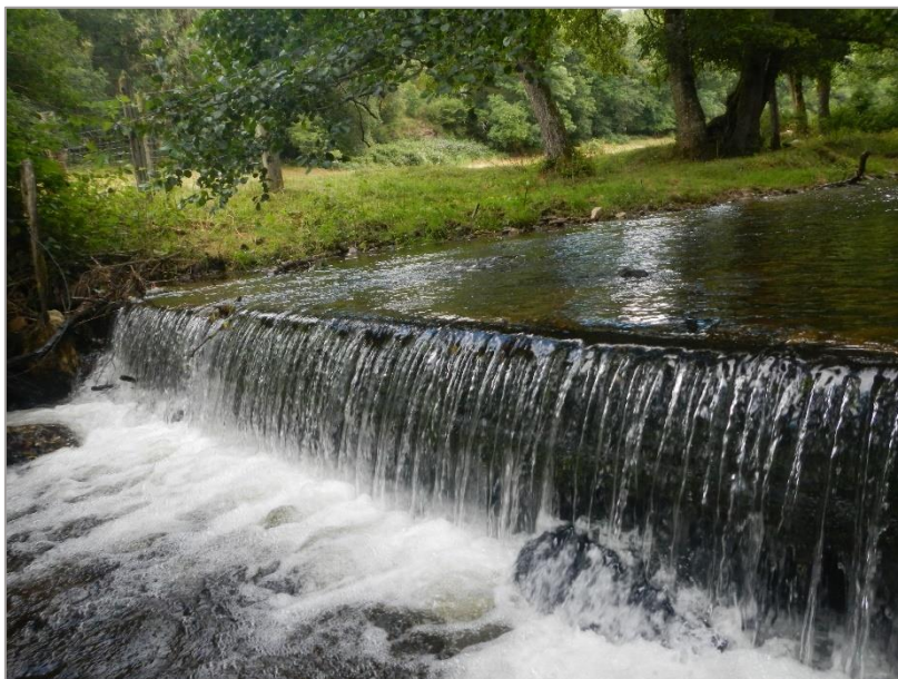
Figure 67 : Seuil sur le Remontalou
