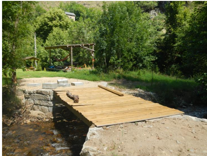
Figure 72 : Passerelle aménagée sur deux enrochements de berge
