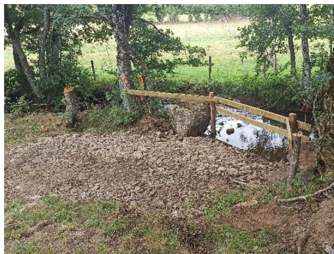
Figure 256 : Abreuvement direct (après travaux)
