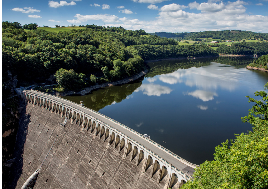
↑ Barrage de Sarrans © EDF-Pierre Soissons
