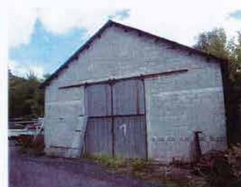
● Enveloppe non isolée inapte à assurer la stabilité des conditions climatiques (hangars Testut)
