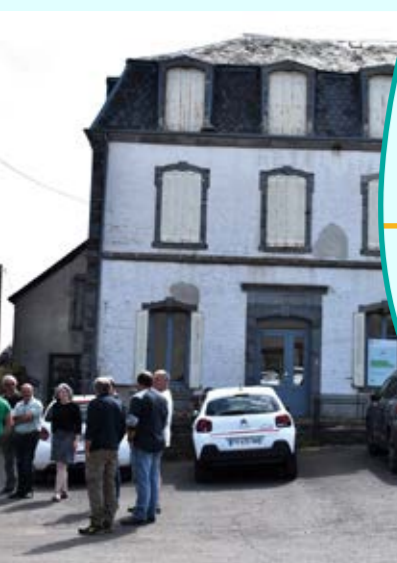
Trois projets de construction ou extension de maisons de santé sont en cours à Neuvéglise-sur-Truyère, Pierrefort et Valuégols
