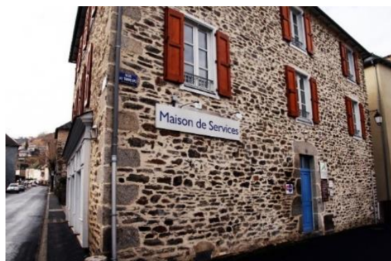
Maison de services de Chaudes-Aigues (Source : Saint-Flour Communauté)
