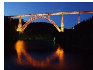
Viaduc de Garabit
