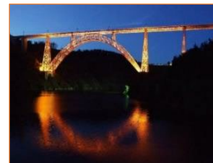
Viaduc de Garabit
