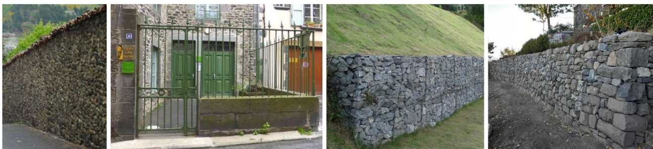
Exemples de murs en pierres locales couvert en tuile, mur bahut avec grilles ajourées, gabion et pierres sèches
