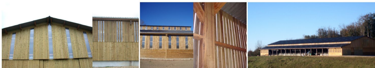
Exemple de façades en bois - source : CAUE15
