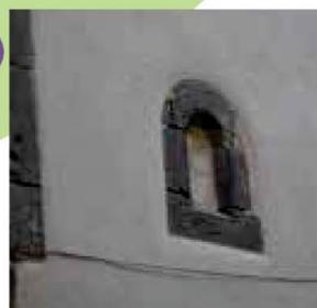
**De manière générale, les appareillages irréguliers, médiocres ou fragiles, de pierre ou de brique nécessitent la protection d'un enduit. La tendance actuelle, de dépouiller les murs de leur enduit pour faire apparaître les pierres au nom d'une hypothétique tradition locale, ne doit donc pas être systématique.**
