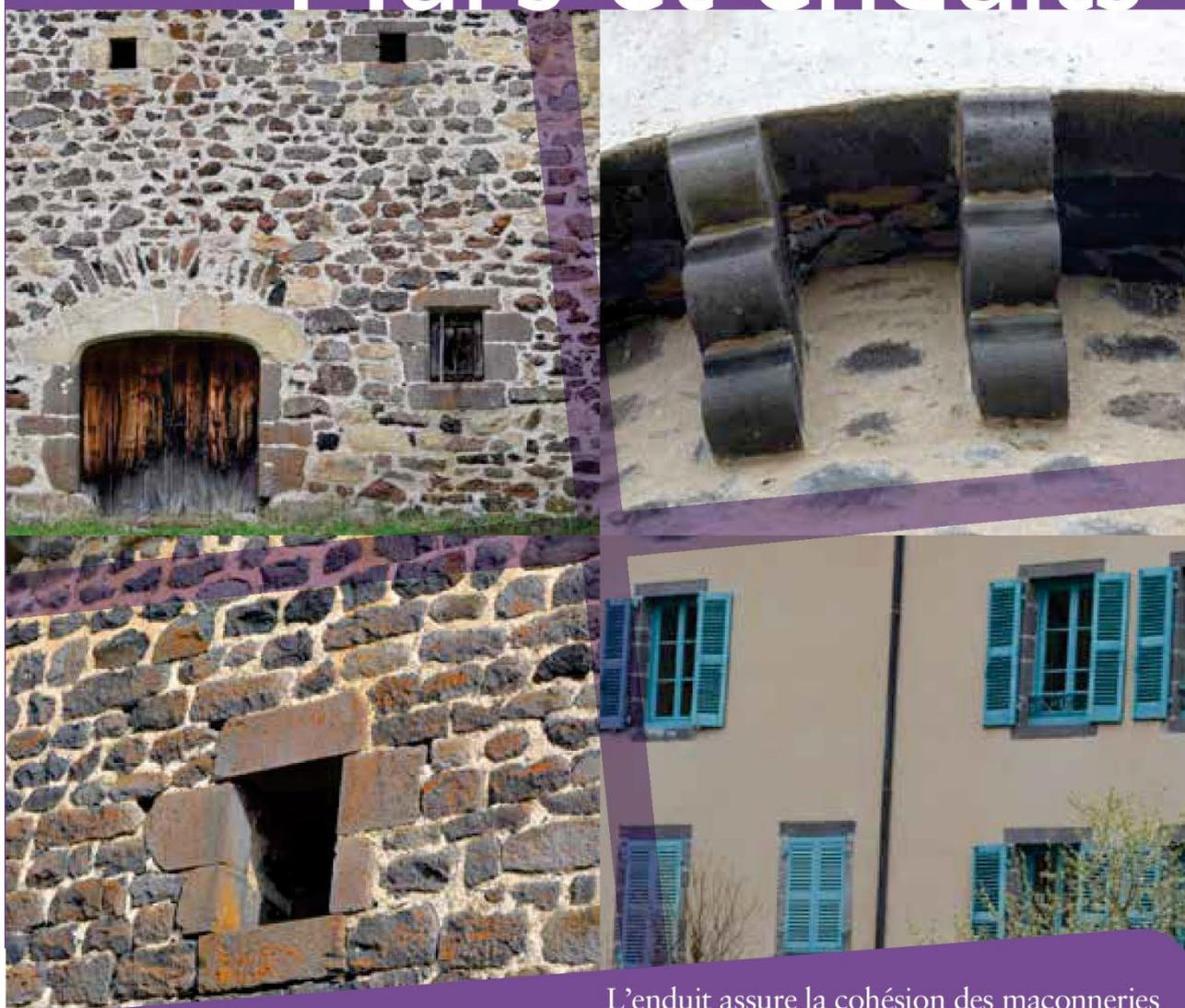
L'enduit assure la cohésion des maçonneries et garantit leur protection contre les intempéries. Témoins de savoir-faire locaux, certains bâtiments conservent encore des enduits d'une grande qualité de mise en œuvre et de résistance. Les différentes finitions soignées de ces enduits leur confèrent un aspect esthétique qui tend à disparaître aujourd'hui.
