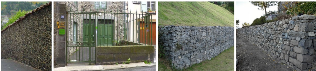
Exemples de murs en en pierres locales couvert en tuile, mur bahut avec grilles ajourées, gabion et pierres sèches
