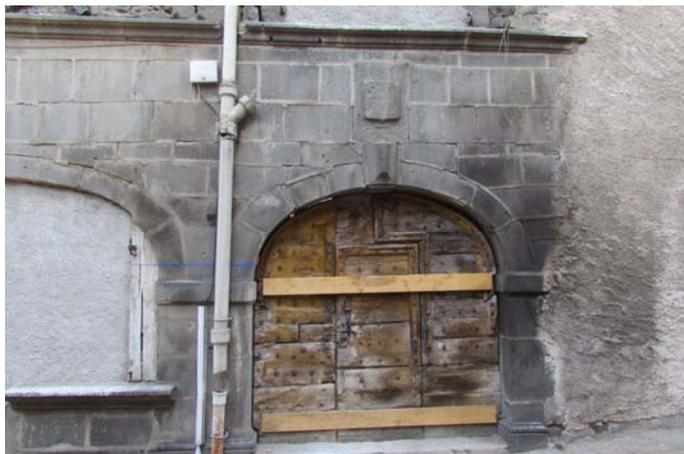
*La position de la chute d'eau pluviale doit être examinée par rapport à l'architecture ; elle ne doit pas « couper » la façade en deux.*
