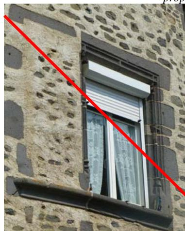
Les volets roulants étant prohibés sur les immeubles anciens, l'occultation doit être assurée par des volets en bois à lames et traverses sans écharpes ou par volets intérieurs lorsque l'encadrement des baies présente une forte modénature
