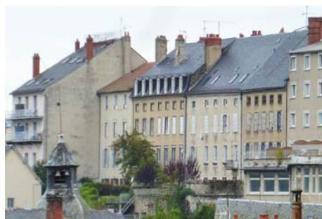
*Bien que la couverture en schiste soit un matériau typique de l'Auvergne, le développement de la couverture en ardoise, à Saint-Flour, s'est fait essentiellement au XIX<sup>e</sup> siècle, à l'arrivée du chemin de fer.*
