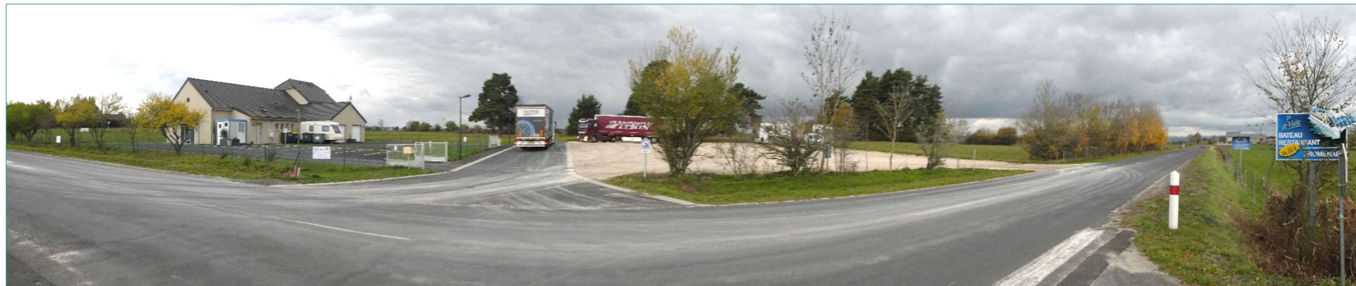
Vue sur l'ensemble déjà urbanisé du site du Drop : bar-restaurant, logement et parking poids-lourds, depuis l'intersection entre la RD909 et la rue de la Cantarise © Campus Développement – novembre 2022
