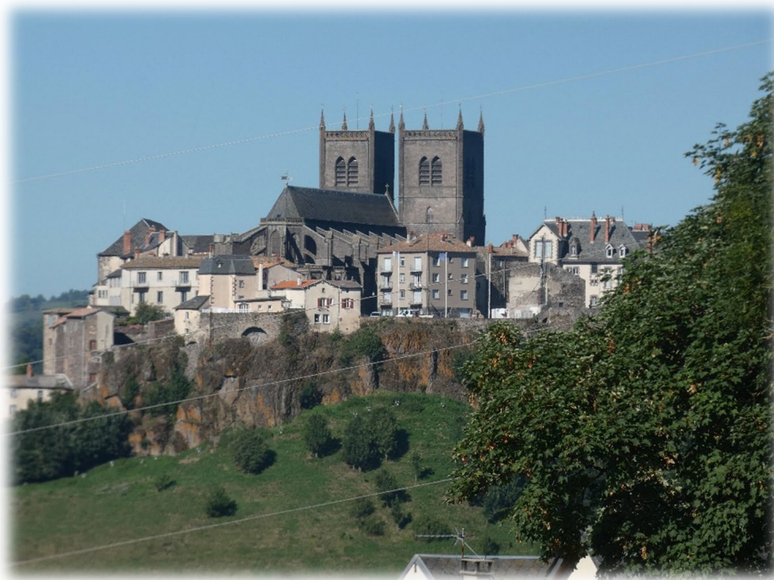
Eglise de Saint-Flour, pour laquelle une protection des combles pourrait être envisagé
