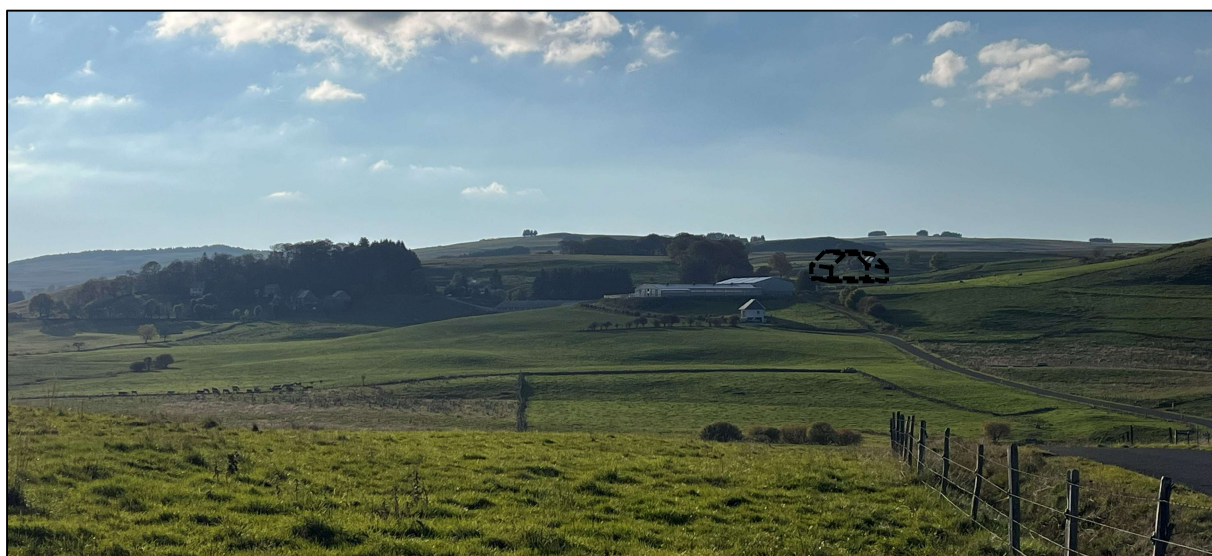
Vue de l'est : bâtiments d'élevage existants et projet envisagé
