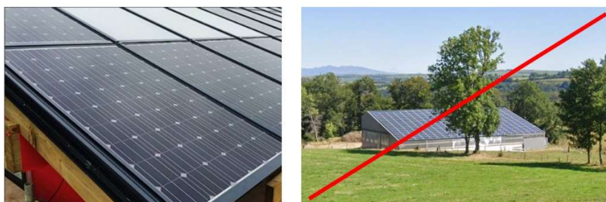
Teinte des panneaux et structures photovoltaïques
