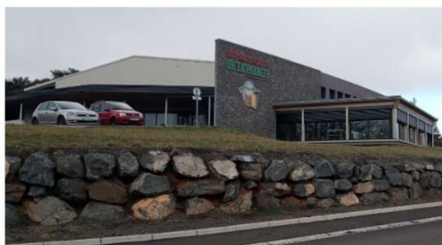
Exemples de talus végétalisé, enrochement de pierre locale et gabion en pierre locale
