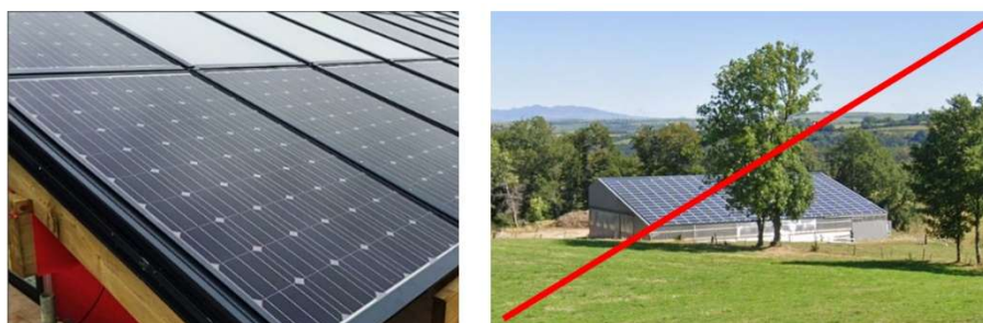
Teinte des panneaux et structures photovoltaïques
